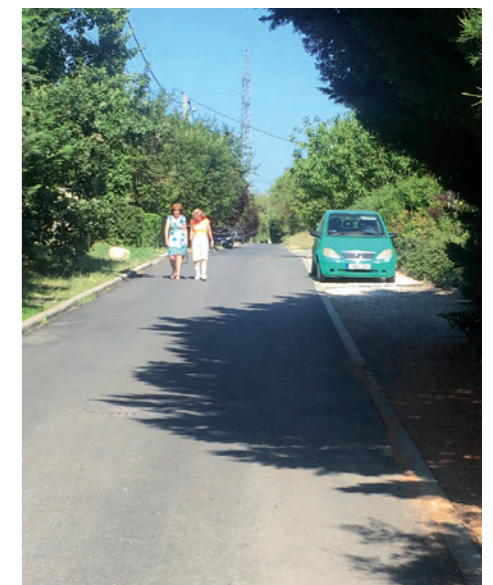
Útépítés a Kenderföld utcában
